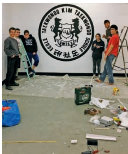
Beim Umbau helfen alle mit
